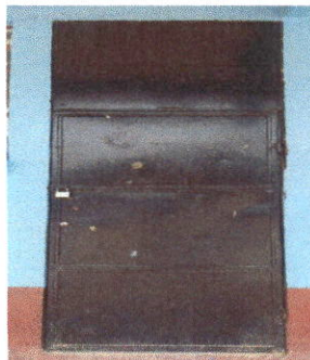
Foto 6: Puertas en mal estado, por lo que necesitan cambio completo. Chapa ya no sirve, junto con el resto de material.
